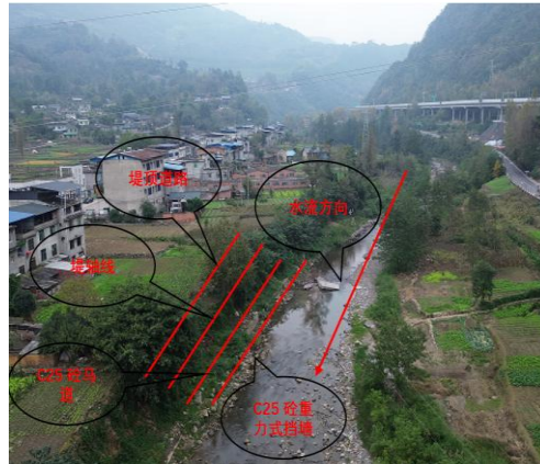
Y2K0+000 右岸堤防
