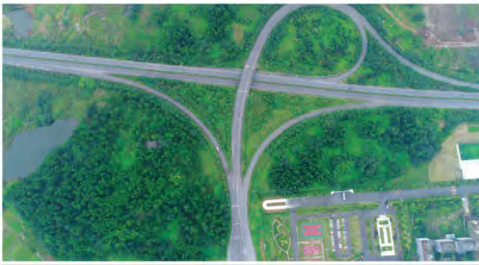
● 符溪黑桥高速公路交通枢纽 (峨眉新闻网 供)
