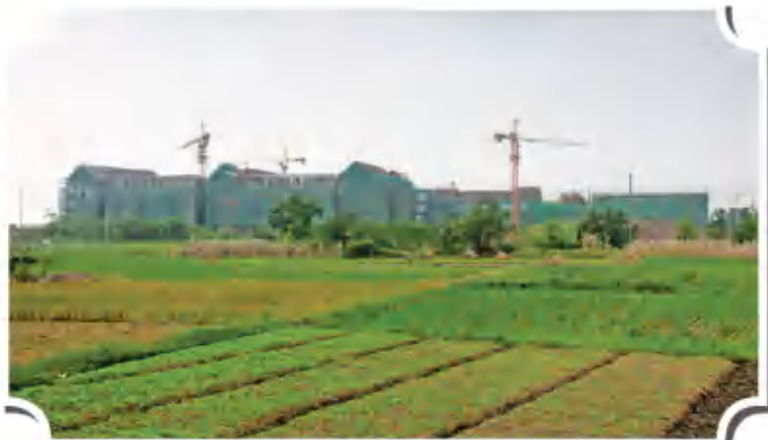
● 峨眉二小迁建工程，2018年3月正式进场施工，已完成项目主体封顶建设 (黄秀林 供)
