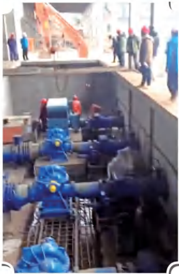
● 峨眉山市第三水厂取水口迁扩建工程，2018年2月开工，仅用十个月时间完成工程建设，提前实现试通水 (峨眉新闻网 供)
