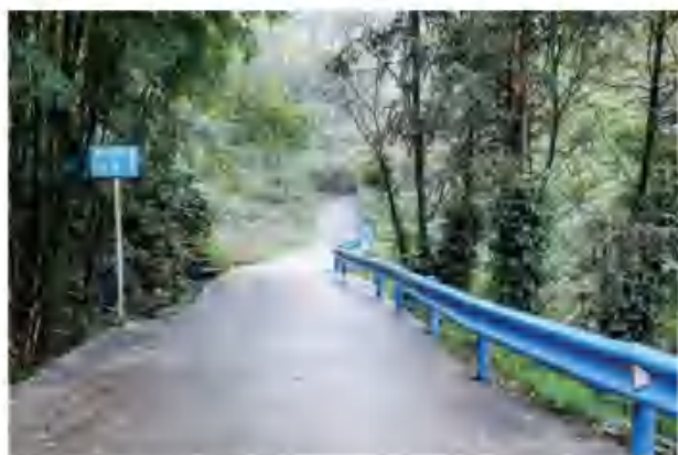
村级道路升级改造，建设美丽乡村（市融媒体中心供）
