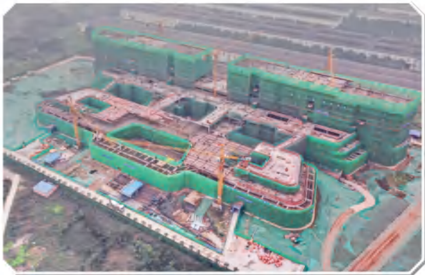
12月，峨眉山市人民医院主体工程建成（市融媒体中心 供）
