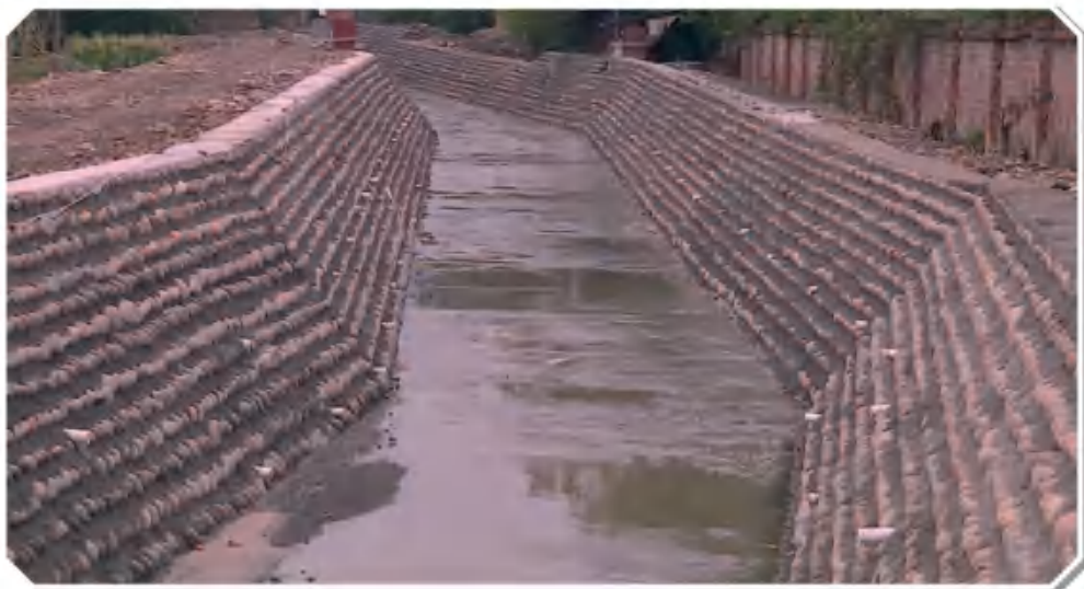
1月26日，峨眉山市东部片区防水排涝项目（二标段）工程竣工（市融媒体中心 供）
