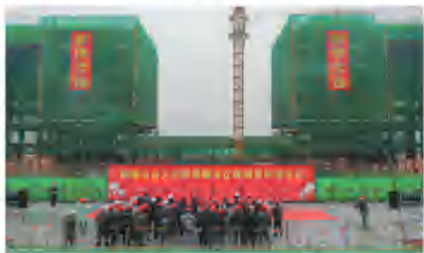
12月31日，市人民医院迁建项目主体封顶（市卫生健康局 供）
