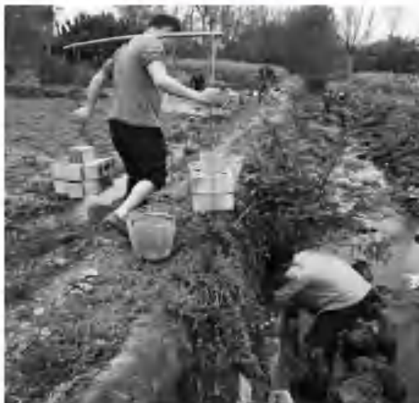
整修改善农业基础水利设施（桂花桥镇 供）
