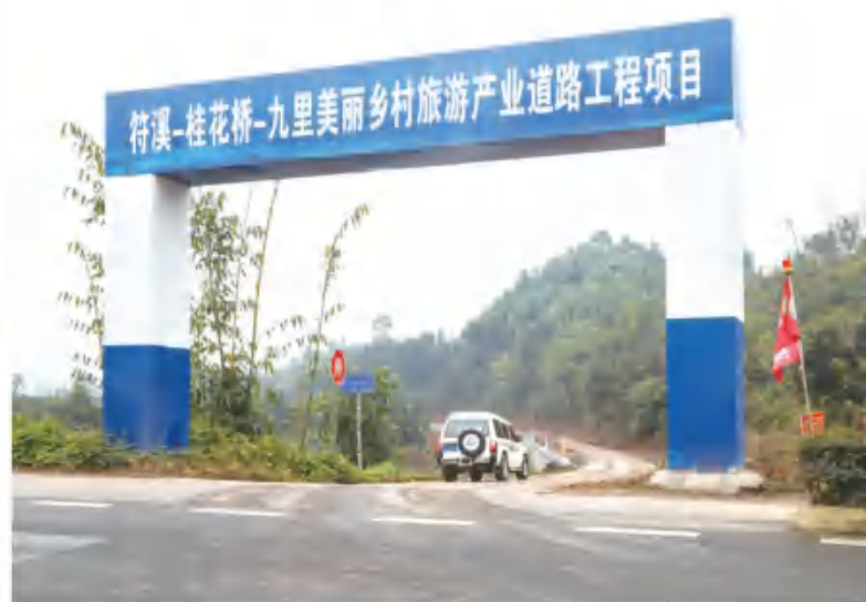
◎ 5月15日，“符溪—桂花桥—九里美丽乡村旅游产业道路”开工 (市融媒体中心 供)
